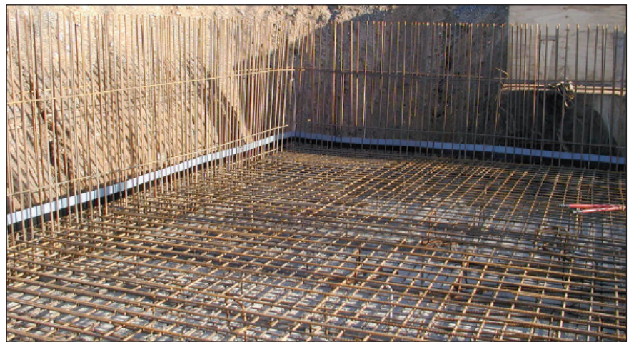
Trekk av det nederste silikonpapiret før støpingen.
