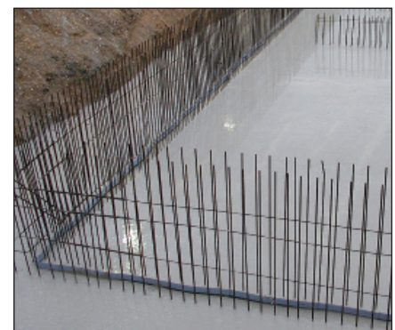
Sikker innfuging i betongen, maksimalt halv platebredde.
