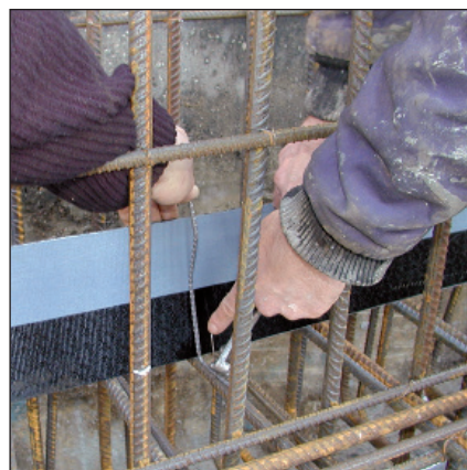
Montering med monteringsklemme på armeringen.
