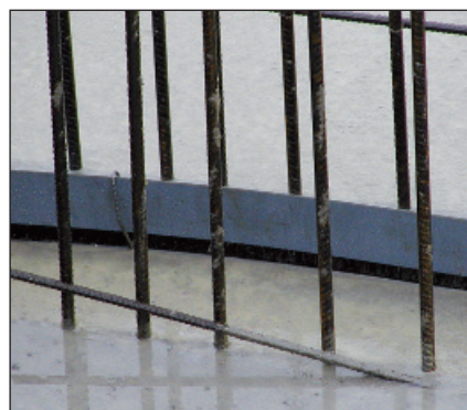
Sikker innfuging i betongen, maksimalt halv platebredde.
